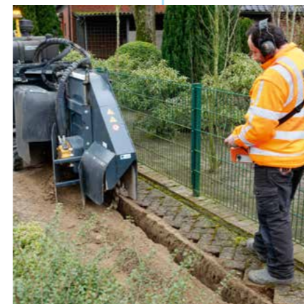
Der Mitarbeiter bedient die Fräse zum Ziehen des Grabens.
