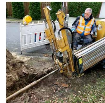
Anwendung des Spülbohrverfahrens
