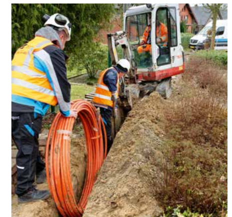
Klassischer Tiefbau per Minibagger
